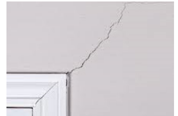
Drywall Cracks
