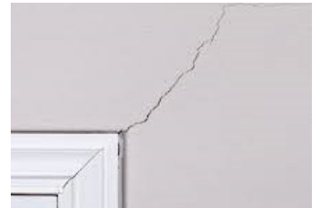
Drywall Cracks
