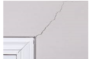
Drywall Cracks
