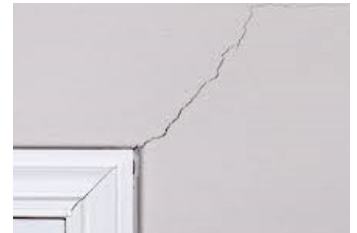
Drywall Cracks
