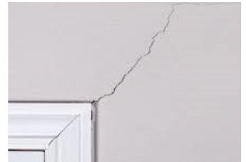
Drywall Cracks
