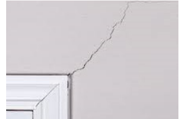
Drywall Cracks
