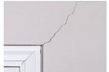
Drywall Cracks
